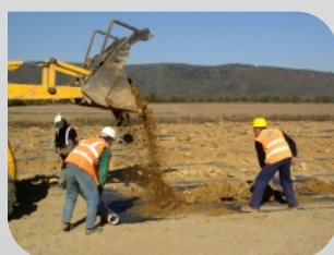
Běloutín - motorway D47
