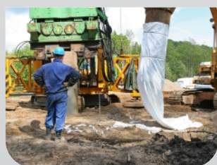
Miedzzydroje – zakládání na neúnosném podloží
