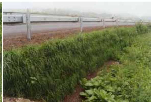
Pohled na ozeleněnou konstrukci (2000)
