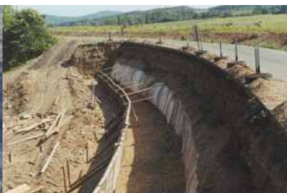
Provizorní bednění pro vytvoření rovného líce opěrné zemní konstrukce z vyztužené zeminy
