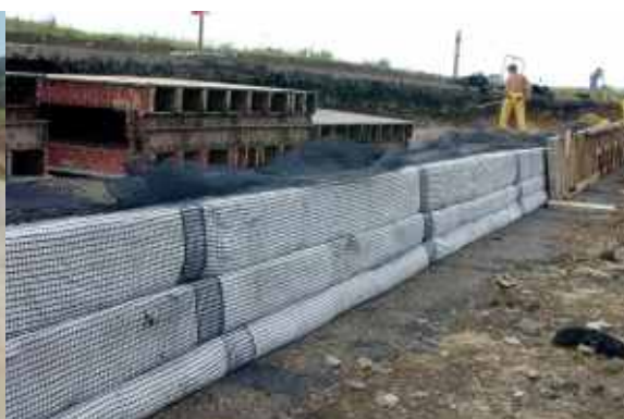
Stavba vyztužené zemní konstrukce (pod geomříží Armatex® G je netkaná geotextilie se semeny trav)
