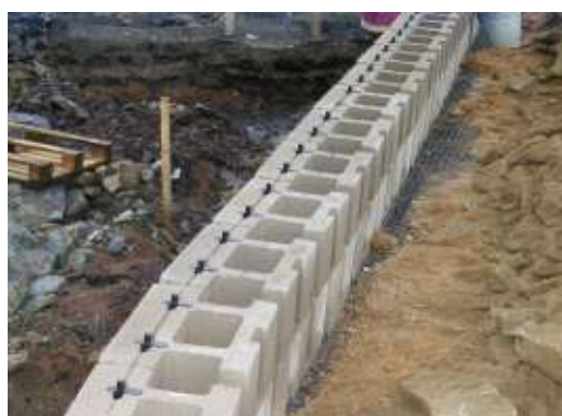
Plastové kolíky pro lícování tvarovek které slouží i pro uchycení geomříže
