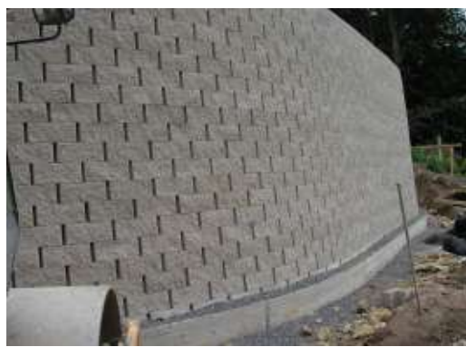
Pohled na segmentovou zeď mostní opěry při stavbě
