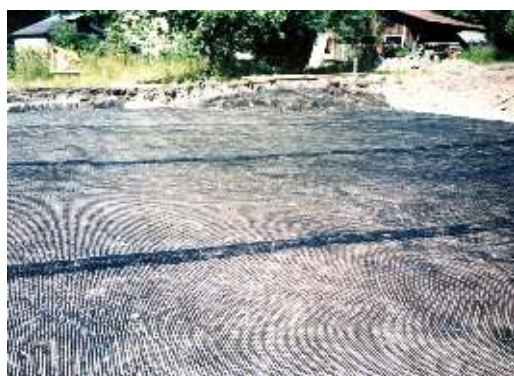
Geomříž Armatex® G 55/30 položená na urovnanou a zhutněnou vrstvu
