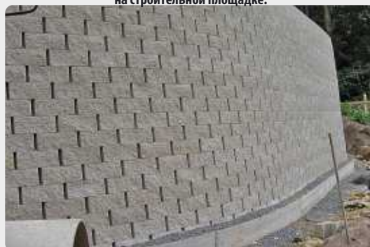
Вид подпорной стены опоры моста, облицованной блоками, на строительной площадке.
