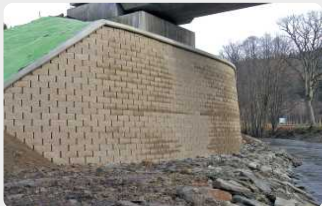
Опора моста, построенная путем армирования грунта насыпи. Поверхность бокового откоса укреплена противэрозийной геосеткой Slovarm.
