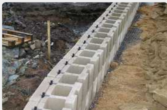
Пластиковые штифты являются фитинговыми соединениями для фиксации отдельных сегментов конструкции (блоков), и используются как анкерные крепления георешетки.
