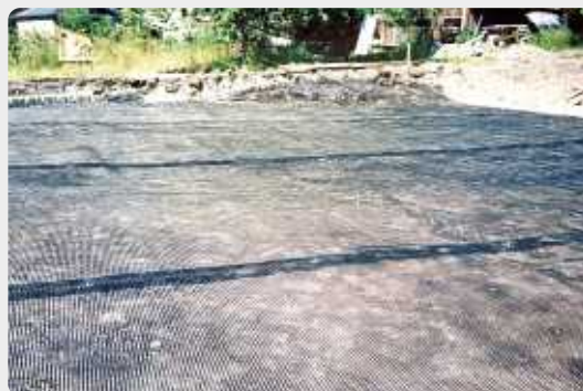
Георешетка Armatex G 55/30 укладывается на выровненный и уплотненный слой грунта.
