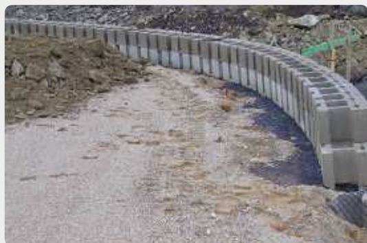
Армирующая георешетка Armatex G 55/30 зажимается блоком, в горизонтальной плоскости, с шагом заложения по вертикали 0,60м.
