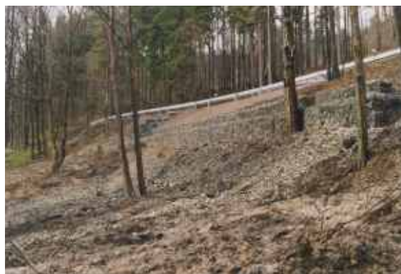
Obr. 5 Svah po sanaci
