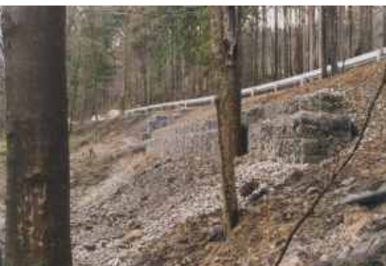
Obr. 4 Svah po sanaci
