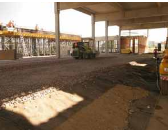
dílčí fáze stavby
