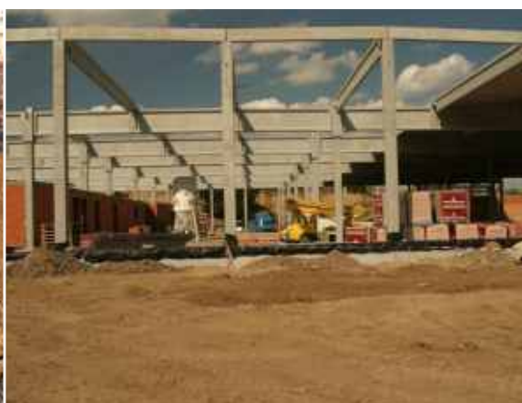
pohled na skelet halového systému OC
