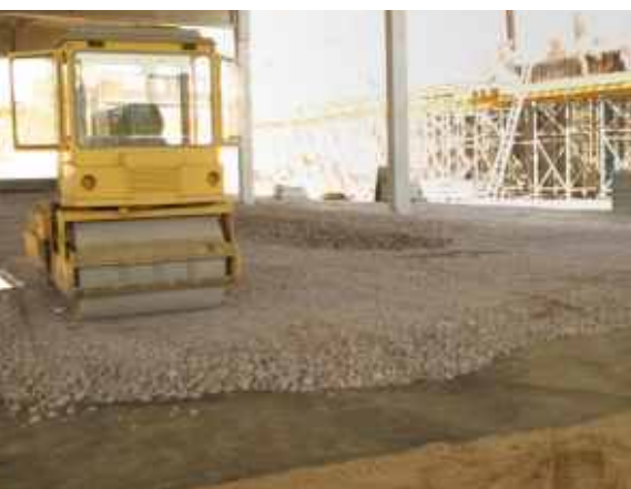
hutnění vrstvy kameniva
