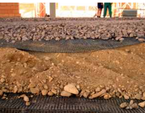
skladba konstrukčních vrstev
