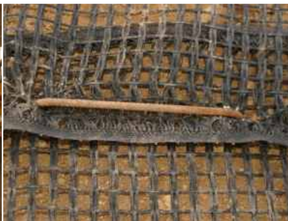
kotvení podélného přesahu geomříže ocelovou sponou
